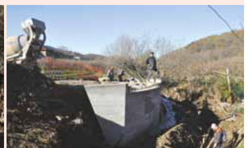
Izgradnja mostu v Oševlju
