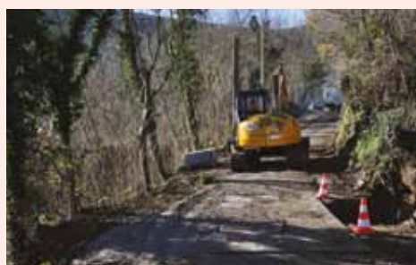
Obnavljanje ceste na Vinišče
