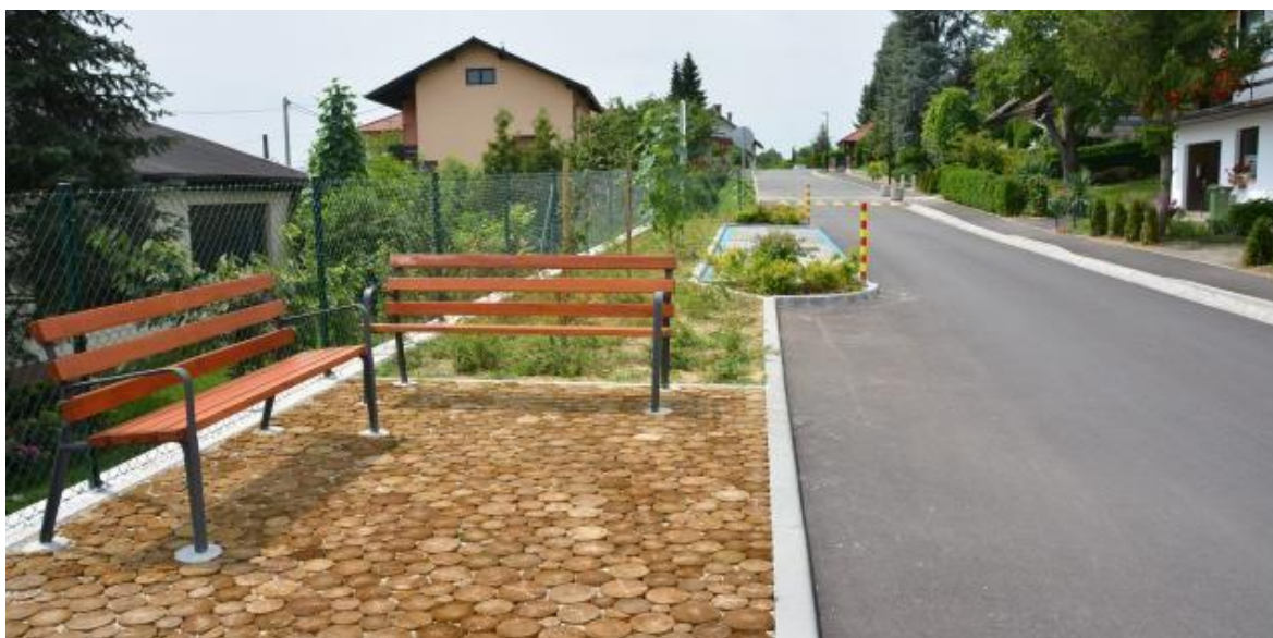
Slika 19: Primer umirjanja prometa v stanovanjski ulici v Ljutomeru
