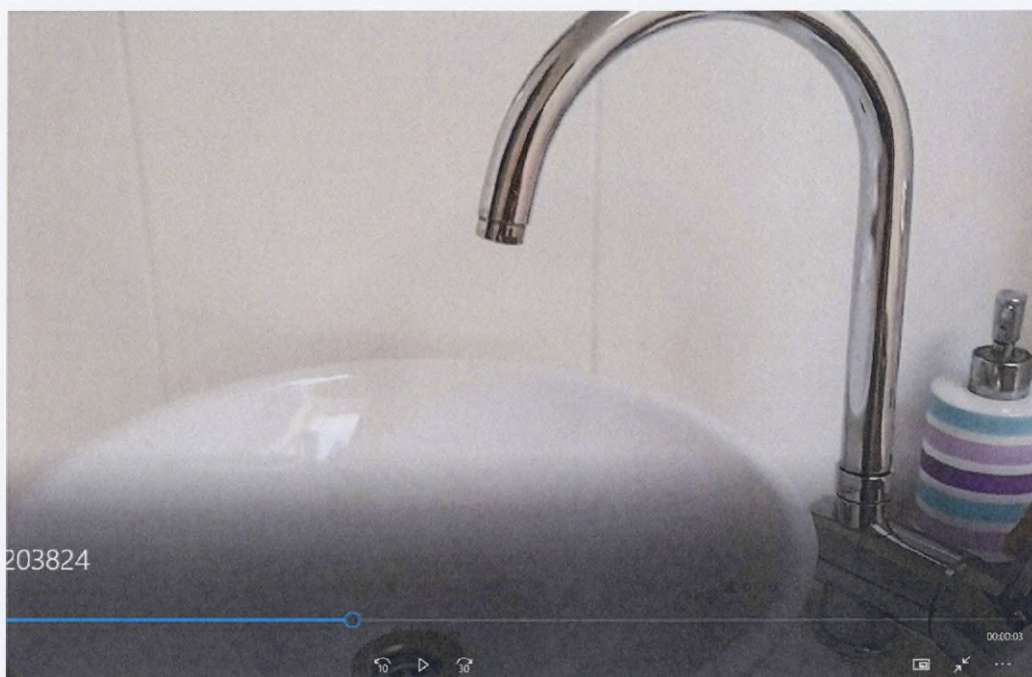
Slika 3: V primeru, da je tlak na merilnem priključku nižji od 1 bar ni dotoka vode (video prikazuje, da kljub odprtem vodovodnem ventilu ni dotoka vode_ snemano dne 16.6.2022 okoli 21 ure na lokaciji Vogrsko 61b).
