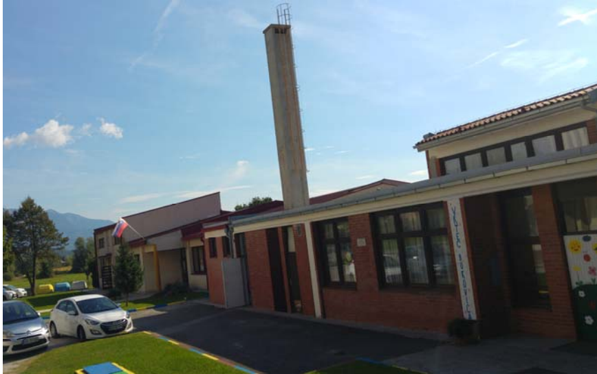
Pogled na stavbo s severa
